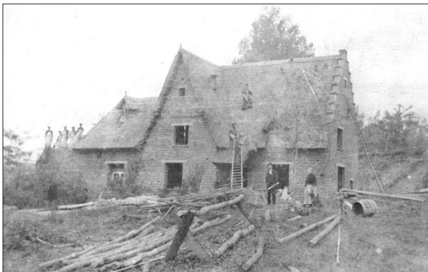
LA MAISON DEVOS EN COURS DE CONSTRUCTION 1893 ((COLL MUS.COM))
